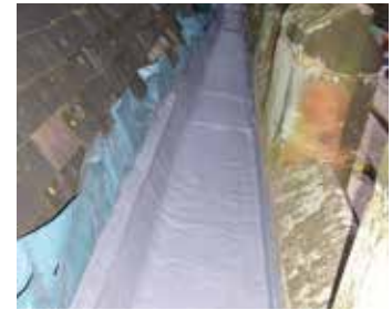
Juntas de canaletas
