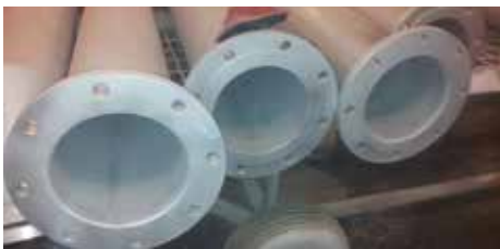
Antes, durante y después de una aplicación de Belzona 1381 mediante pulverizador en el interior de una tubería.
